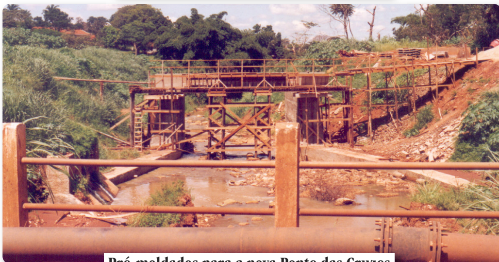
Pré-moldados para a nova Ponte das Cruzes.
